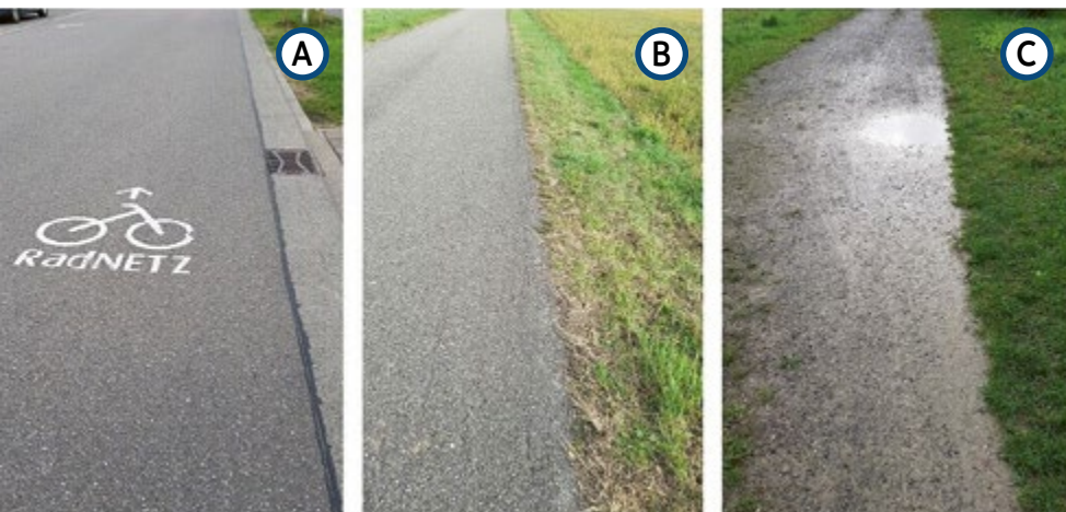
Bild A – versiegelt mit seitlichem Ablauf des Wassers in die Kanalisation, Bild B und C – ebenfalls versiegelt, jedoch mit seitlicher Versickerungsmöglichkeit. © Klaus Mutterer
